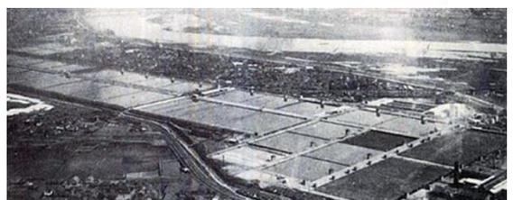
大阪市柴島浄水場では淀川の水を取水する導水路で硫酸バンドを注入してから緩速ろ過をしていた。
