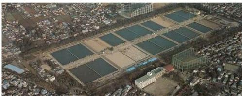
水源の貯水池で硫酸銅で殺藻処理をしていたので、ろ過池が直ぐに目詰まりし、削り取りが頻繁だった。
