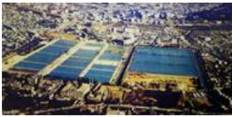
戦前、明治中頃から東京市淀橋浄水場（現在の新宿西口、新都心）の沈殿池で硫酸銅で殺藻処理をしだした。この水を緩速ろ過処理をしていた。
