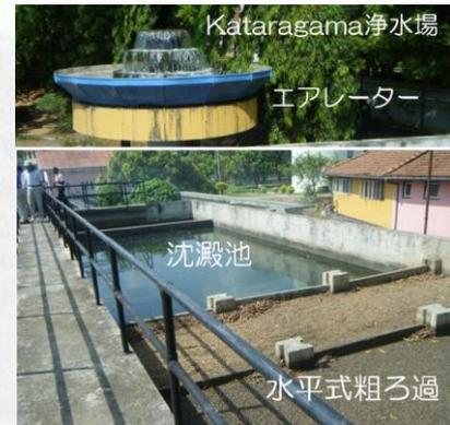
図22 エアレーターと水平粗ろ過
