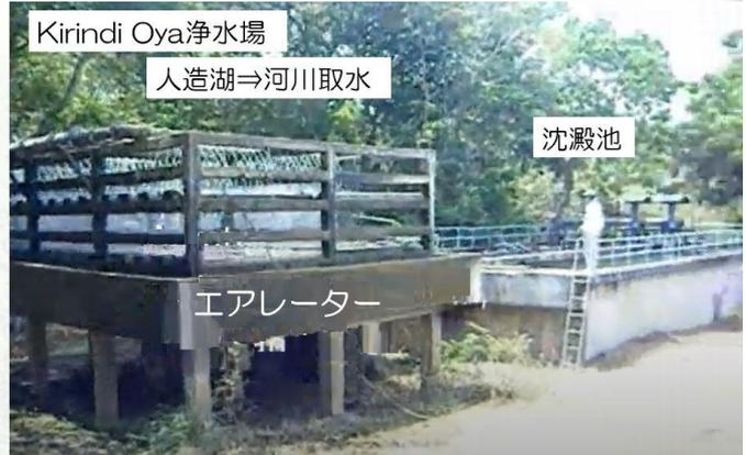
図24 エアレーターと沈殿池
