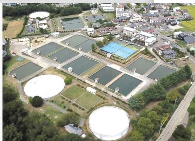
図4. 染屋浄水場 (市パンフより)
