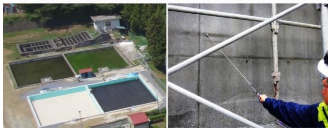
図11. 大船渡市の浄水場とろ過池調査
