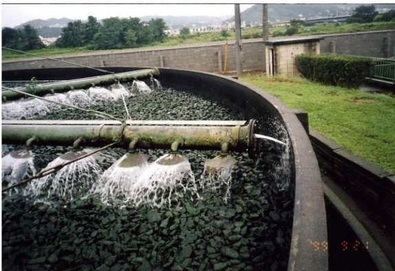
図22 ろ床ハエの羽化対策
