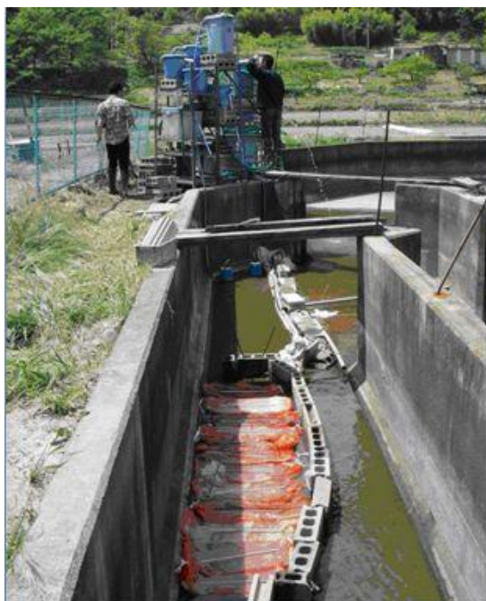
図12-3・4. 濁り物質が少ない水をつくる工夫。タマネギ収穫ネット、暗幕で遮光、汚泥ポンプで揚水、水圧調整槽、上向き粗ろ過。
