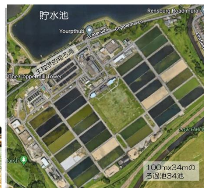
図35 カッパーミルズ浄水場
