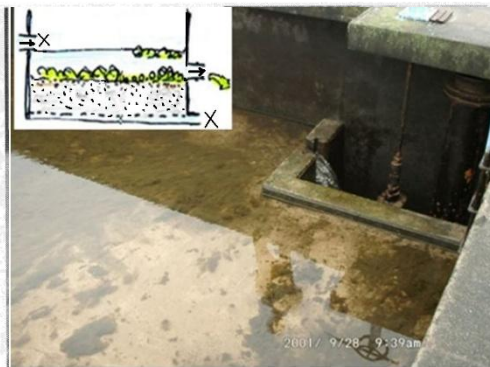
図43 砂面排水と砂面上の汚れ
