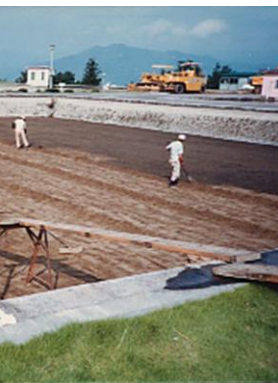
図33 手作業での削り取り
