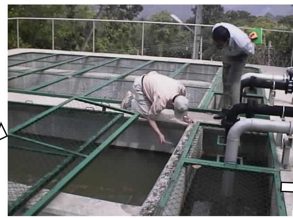
沈殿槽 3槽 排泥操作を考えた
