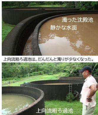
図25 粗ろ過水を確認する
