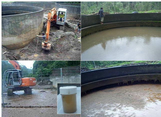
図30 粗ろ過の汚泥除去
