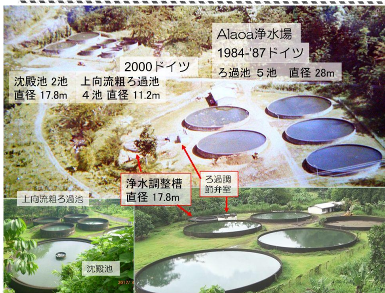
図1 アラオア浄水場
