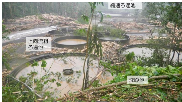
図13 流木だらけの浄水場
