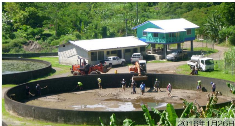
図26 砂面の汚泥除去作業
