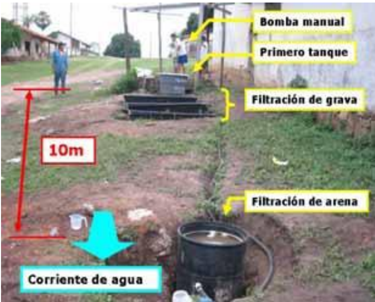
Use of natural slope, pour in sand filter
