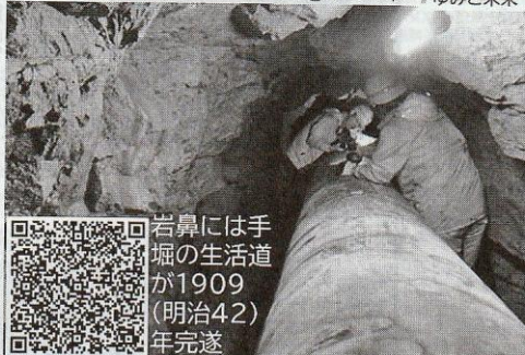
図14 手堀隧道内を点検作業
