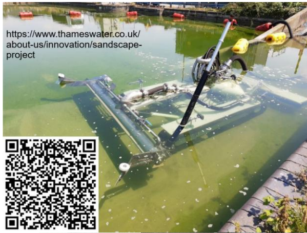
図40 砂面上の汚れを吸引で除く
