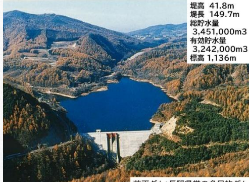
菅平ダム:長野県営の多目的ダム(かんがい・上水道・水力発電)
