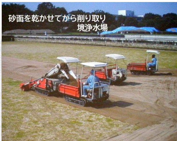
図18 乾かして削り取りで砂が汚れる
