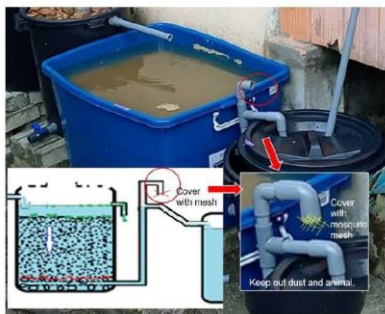
6-5 URF 上向流粗ろ過の上に少し水が見えると、きれいな水かできているかを見る事ができる。
