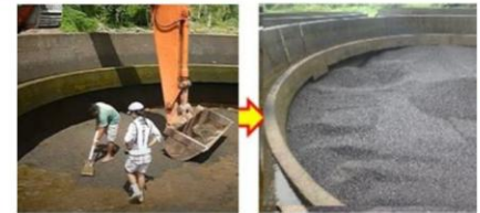
7-16 URF での濁り対策を大きくするために、礫を補充し、礫層を増やした。礫表面の面積を増やす事で、濁り付着面積を増やした。
