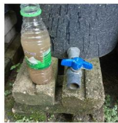
6-8 砂ろ過池、上向流粗ろ過槽に藻が繁殖。排泥をしてみた。
