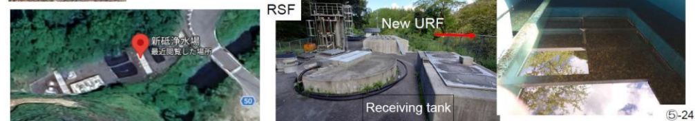
5-24 小規模簡易水道施設の急速ろ過器を止めて、3 段の URF を挿入した。
