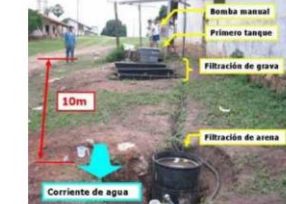
Use of natural slope, pour in sand filter
