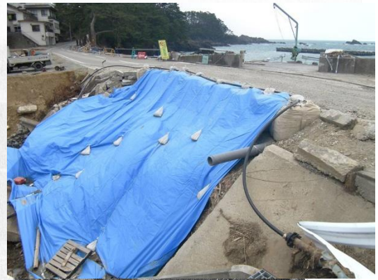
図12 震災後、仮配管
