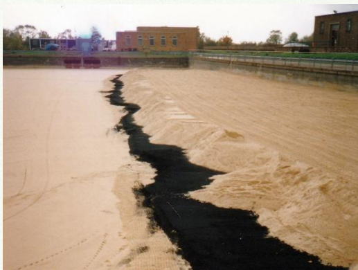
図16 農薬分解のため活性炭を挿入
