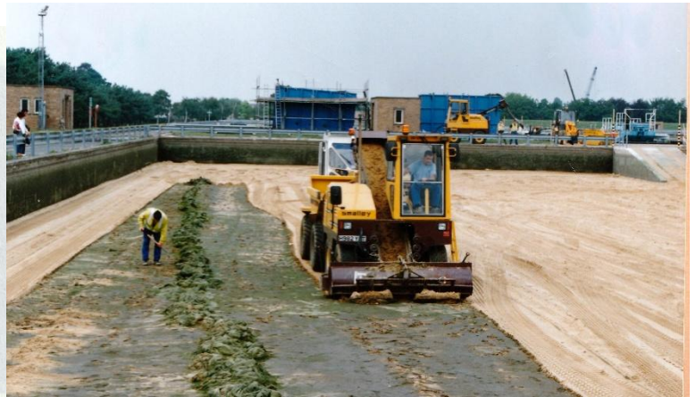
図17 生物群集を除く削り取り
