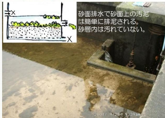
図42 砂層は汚れていない
